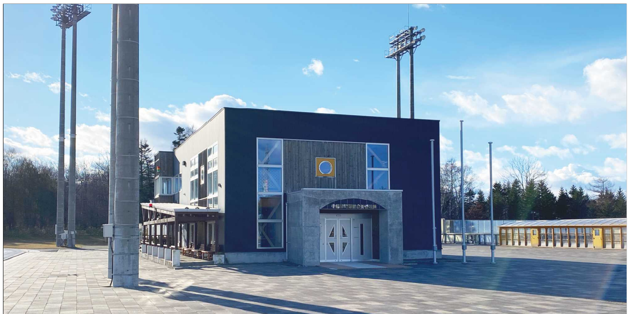
・中標津町運動公園管理棟新築工事（S）
