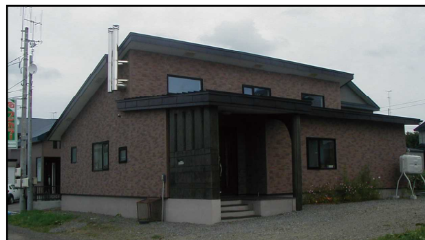
A邸住宅新築工事 / 外断熱補強コンクリートブロック造（S・K）
