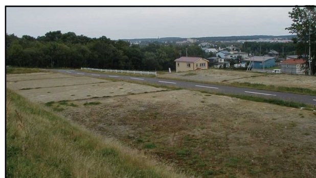
ひだまりの丘 分譲地造成工事
