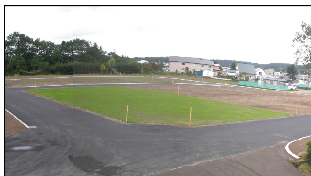
フラワー団地 分譲地造成工事
