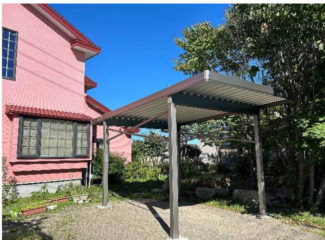
カーポート(建物正面)
